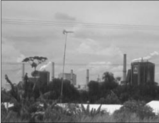
Die Zellstofffabrik Indah Kiat auf Sumatra (Quelle: Happe)
