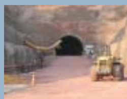
Under construction. © FIVAS and Proyecto Gato.
