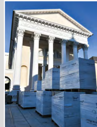
Marktplatz in Karlsruhe im Bau
